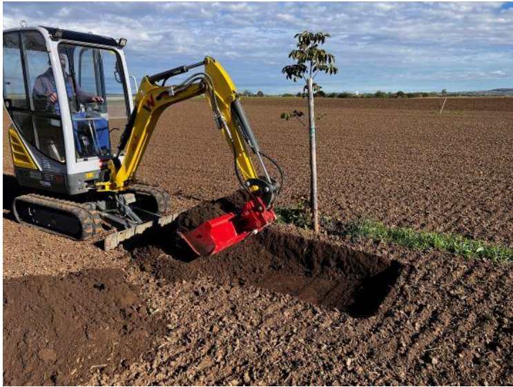
Abb.2: Ausheben einer Profilgrube mit dem Löffelbagger.
